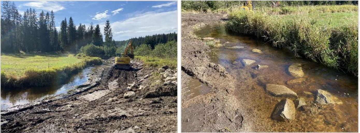
**Abb.: Links: Geschiebeentnahme. Rechts: Neu gesetzte Strukturierungsmaßnahmen.**
